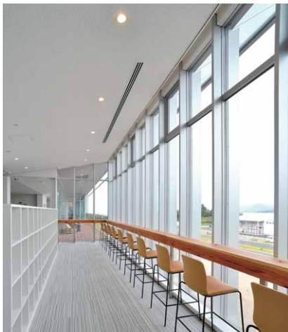
コミュニケーションスペースには昼光センサー連動のLED一体形ダウンライトを配置
