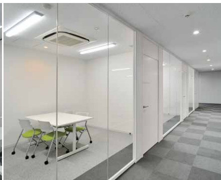
インタビュールームと廊下のLED照明
