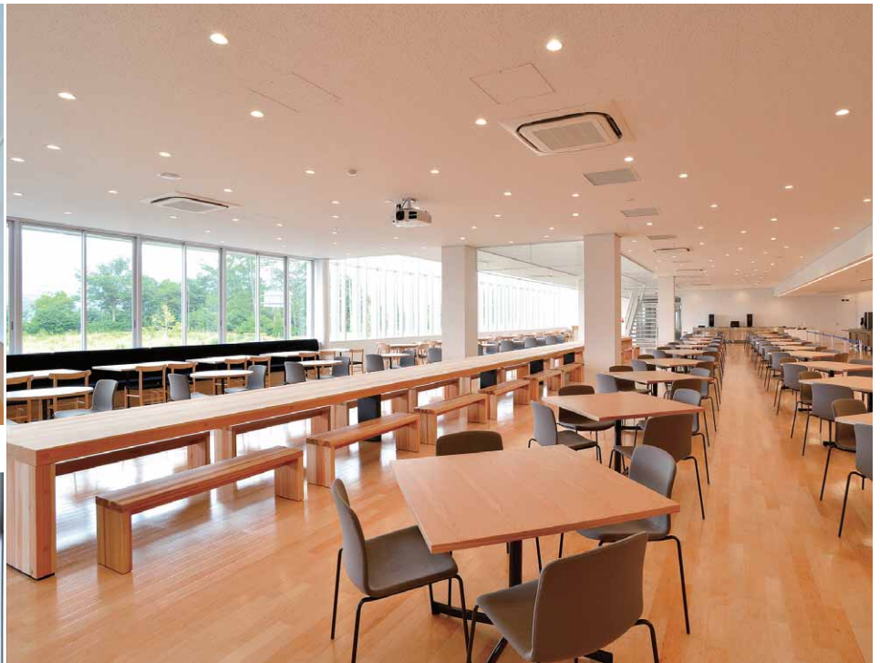
LED一体形ダウンライト調光タイプがランダムに配置された食堂の照明
