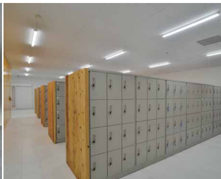
ロッカー室のLED照明(AQシリーズ直付形)
