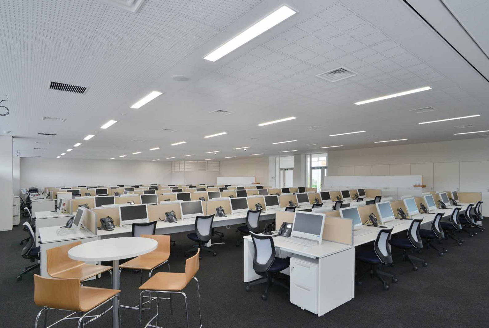
LEDベースライトAQシリーズ昼白色の埋込形を採用し、省エネしながら開放感・快適感が得られているオペレーションルーム
