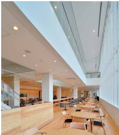
ガラスカーテンウォールの吹抜天井には高出力のLED一体形ダウンライトを設置
