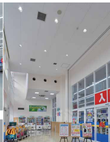
エントランスは高さ約8mの天井面にLED一体形ダウンライト9000シリーズを整列配置
