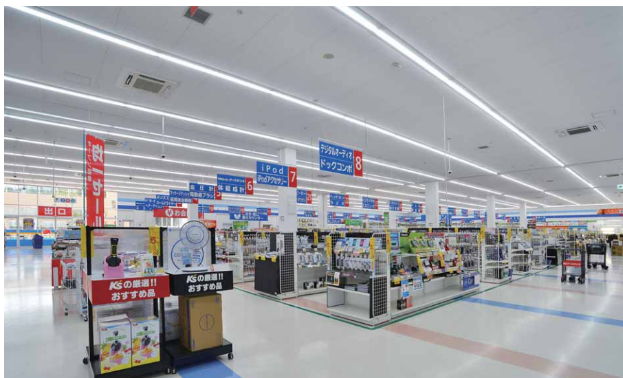
薄型テレビコーナー付近より店舗全体の照明を望む LEDベースライトAQシリーズ110タイプが白い天井面に美しい昼光色のラインを形成
