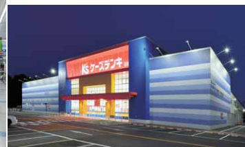
エントランス上階に設置された内照式看板の夜間照明
