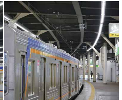
電車昇降時に足元を明るく照射しているLED器具
