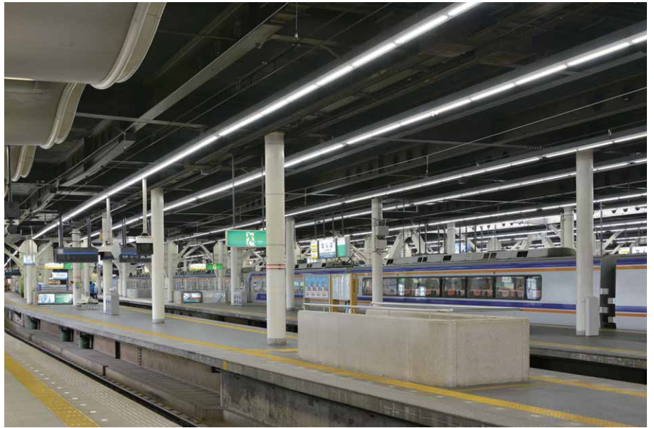
各ホームにライン状に配置されたLEDベースライト（9番ホーム南側より北側を望む）
