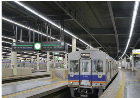
LEDベースライトの光がまわり込み天井面の明るさ感も向上
