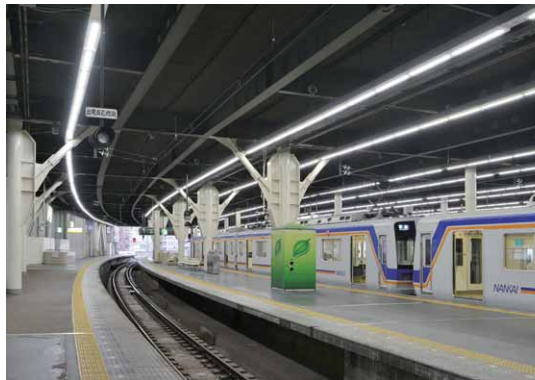
ホームの曲線に合わせて配置され線路内にも明るさを確保（1番ホーム中程より南側を望む）
