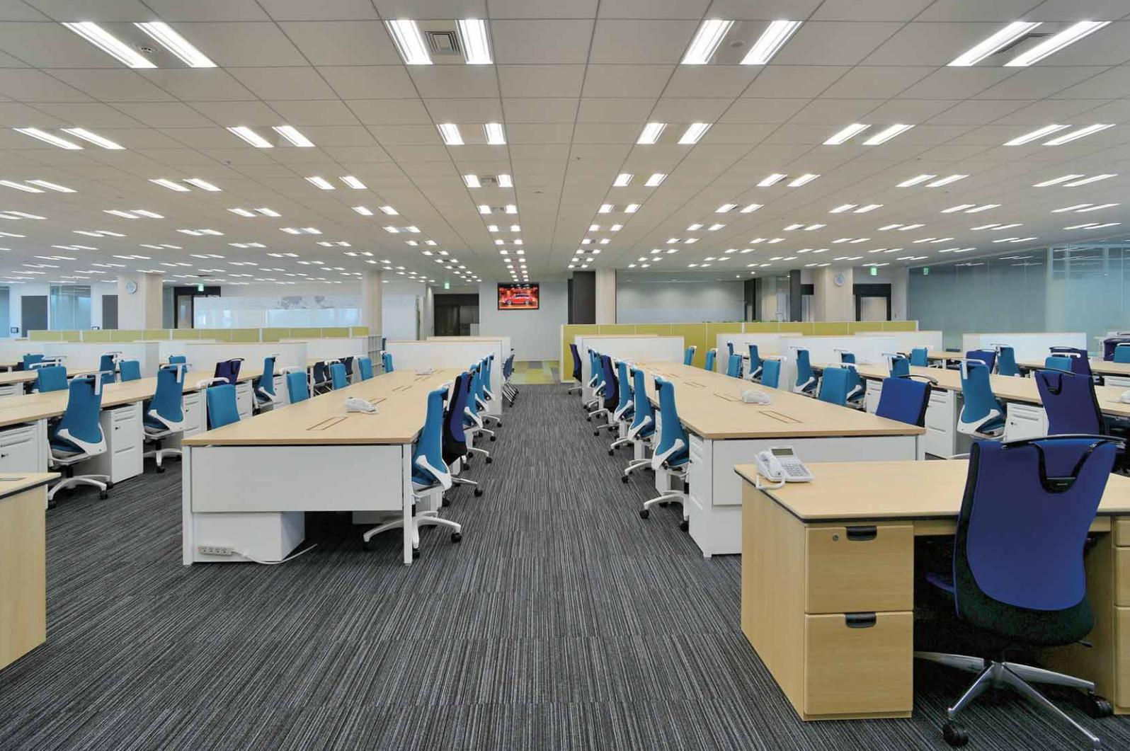
奥側から出入口方向側を望む。1,800mmピッチで均等配置されたLEDシステム天井用グリッド照明器具
