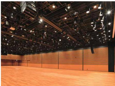
天井全面のグリッドパタンにLEDシアター用ダウンライトと各種ハロゲンスポットライトを設置
