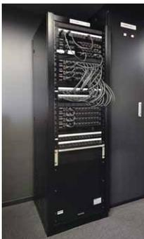
調整室に設置された調光制御信号パッチ盤
