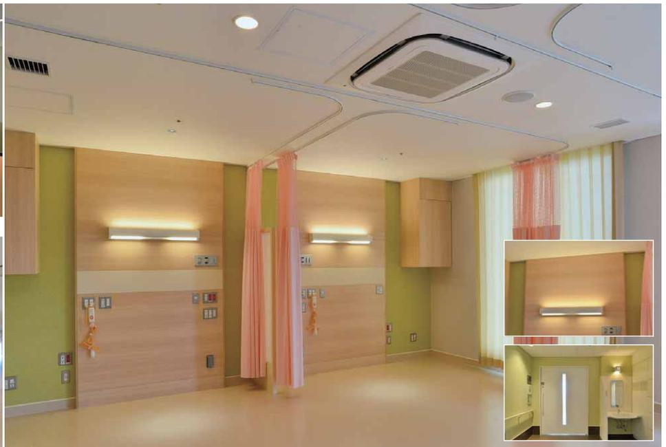
4室タイプの病室 LEDダウンライトをベース照明とし、ベッド灯と読書灯を一体化したLEDベッド灯を採用。処置灯はベッド上部にLEDユニバーサルダウンライトを、洗面上にはLEDブラケットを配置
