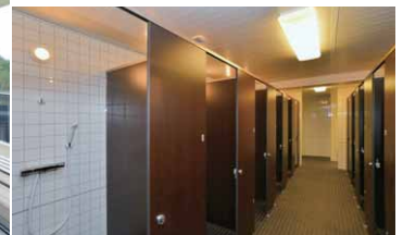
シャワールームのLED照明
