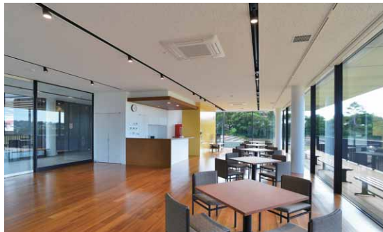
ブラックアウトしたライン状のスリット内にライティングレール+LEDスポットライトを配置
