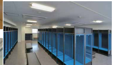
ロッカールームのLED照明
