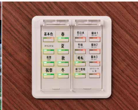
バンケットホール内に設置されたスイッチ。管理するお施主様がワンボタンで簡単に手動操作できるように配慮
