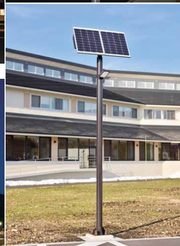
GLよりトップで4m、LEDソーラーライトは3m位置に設置
