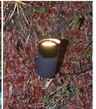
展望台からの景観を損なわないよう、LED小形丸形投光器はルーバーにより1台ごとに漏れ光をコントロール
