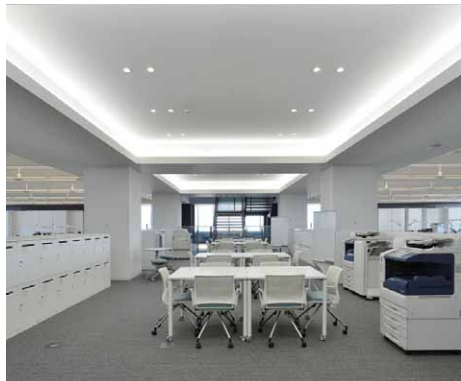
色温度が自動的に切り替わった簡易打ち合わせスペース。5000K時
