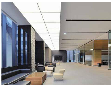
直管形LEDベースライトを使用した光天井により、おもてなしの空間を演出した2階エントランスホール
