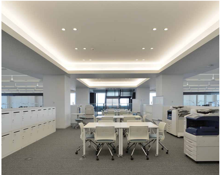
簡易打ち合わせスペースは、1日の時間帯に応じた最適な色温度を自動調色。写真は4000K時
