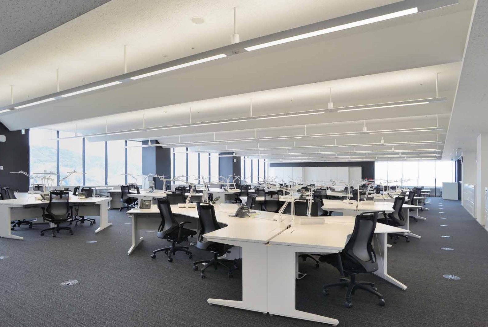
基準階のオフィスに採用した上下配光のLED吊下式アンビエント照明
