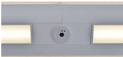
あかりセンサーは、LED吊下式アンビエント照明の連結部に設置
