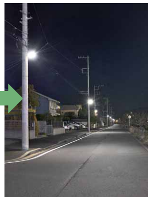
LED防犯灯の点灯時の様子
