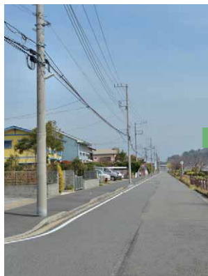
LED防犯灯は電柱の地上4.5m高に取付バンドで固定
