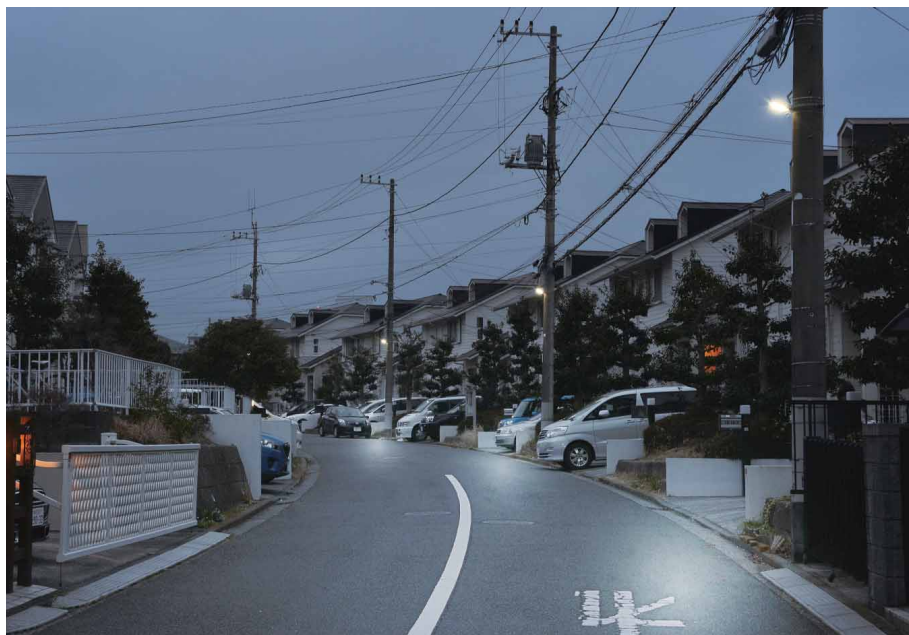
LED防犯灯(10VA)に更新した横浜市の夜間点灯時
