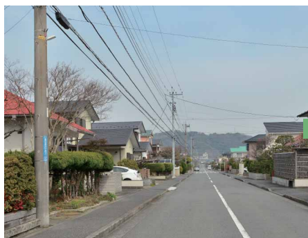
LED防犯灯に更新した昼間の生活道路
