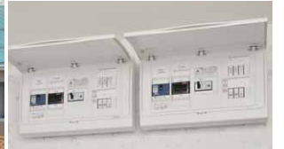
非常時に使用する2系統の蓄電システム用分電盤は、保育士の控室に設置
