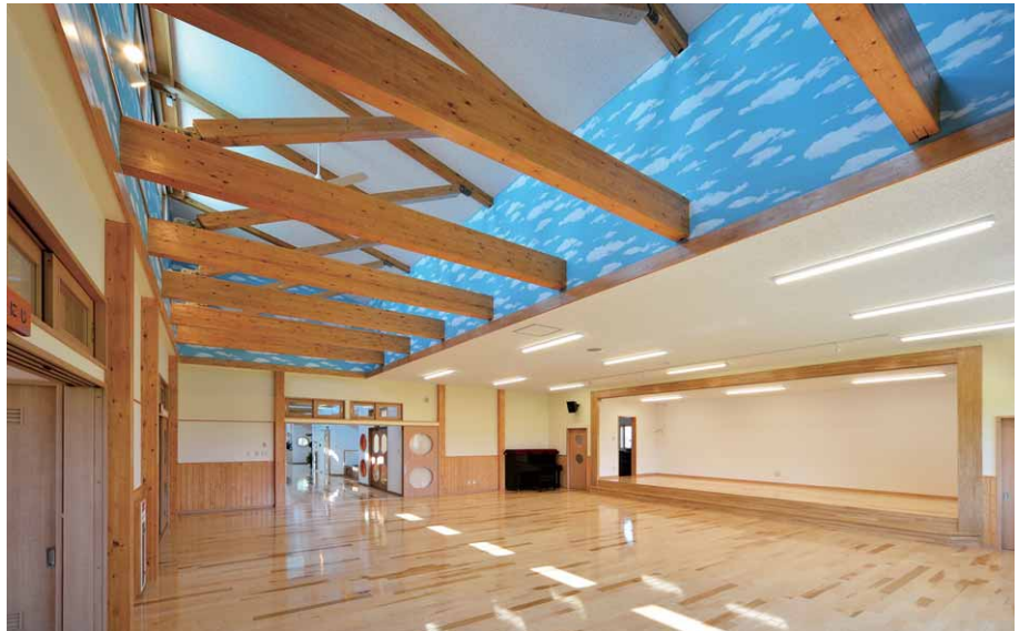
天井部にLEDベースライトAQシリーズを配置し、明るく広々とした空間を演出したホール
