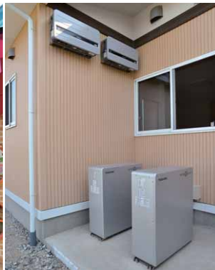
定置式家庭用蓄電システム(下)、太陽電池モジュールで発電された直流電力を交流電力へ変換するパワーコンディショナ(上)は屋外に設置
