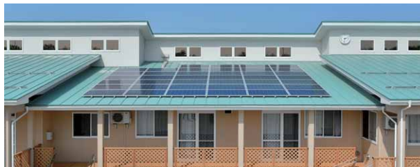
平屋の建物屋根中央部に設置された太陽電池モジュール
