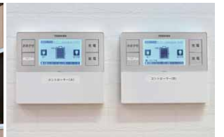
廊下に設置されたコントローラー。2台の定置式家庭用蓄電システムに対応
