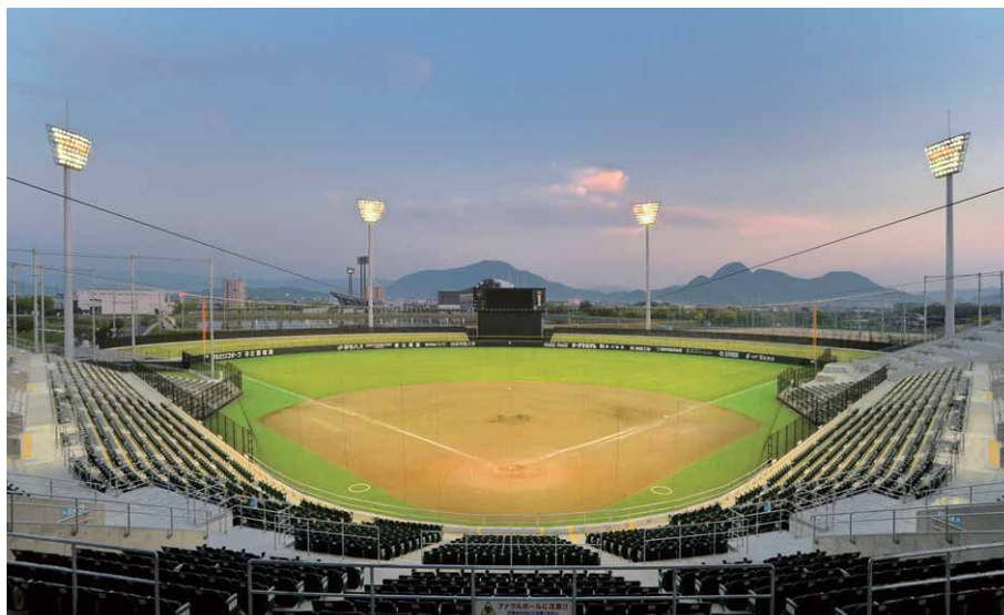
計6基の照明塔はそれぞれルーバー内蔵の1.5kWメタルハライドランプ投光器と940Wナトリウムランプ投光器による混光照明として快適な照明環境を確保
