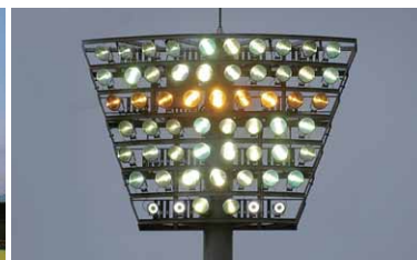
点灯時のHID投光器の照明架台
