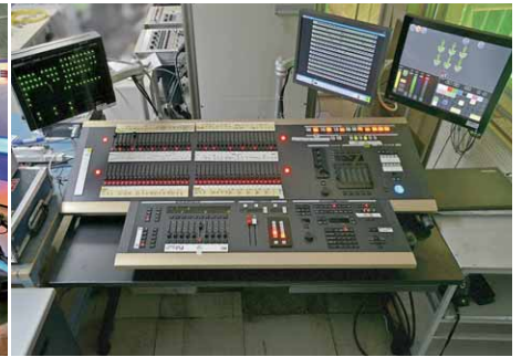
更新された調光操作卓 Versa Station
