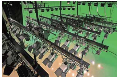
キャットウォークからLEDスタジオ照明を望む
