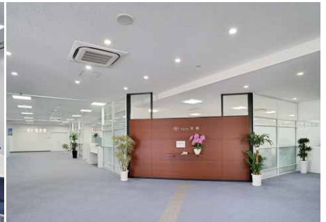
エントランスホールにはLEDライトエンジンダウンライトを均等配置
