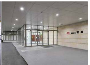
軒下用LEDライトエンジンダウンライト採用の玄関周り
