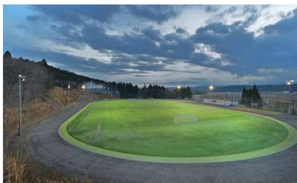
東側から望む 照明柱6基に設置されたLED投光器によるナイター照明
