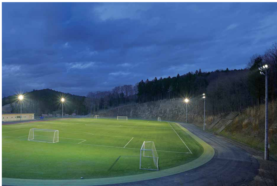
西側からグラウンドを望む 高さ14mの6基の照明柱に計40台のLED投光器を設置した夜間照明
