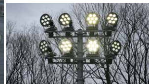
ハーフウェイラインの延長線上に設置された8台搭載のLED投光器
