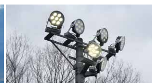
サイドライン用の6台搭載のLED投光器
