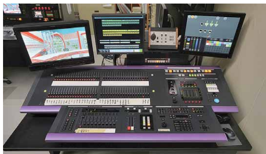
更新された調光操作卓Versa Station
