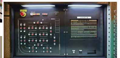
照明ボタン昇降操作盤およびEMG操作盤
