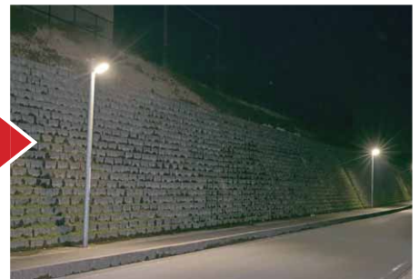
同小学校裏側通学路のLED防犯灯点灯時
