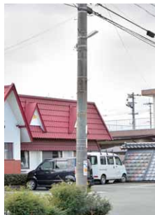
既存電柱に設置したLED防犯灯
