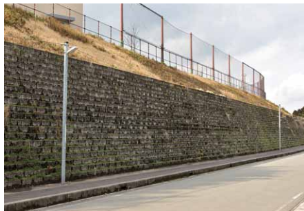
市立西合志中央小学校裏側通学路に設置したLED防犯灯
