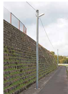
独立柱に設置したLED防犯灯
