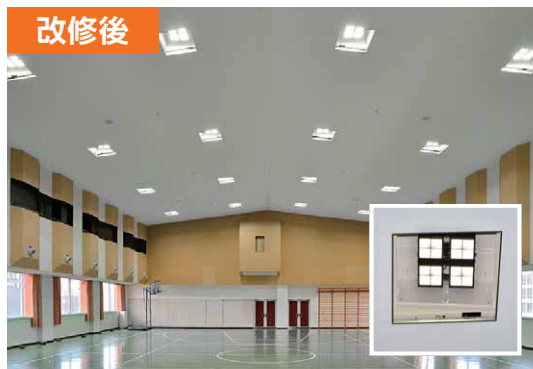
LED高天井器具を採用した改修後の講堂(舞台サイドから入口を望む)
