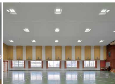
講堂の横から望む改修後のLED照明
