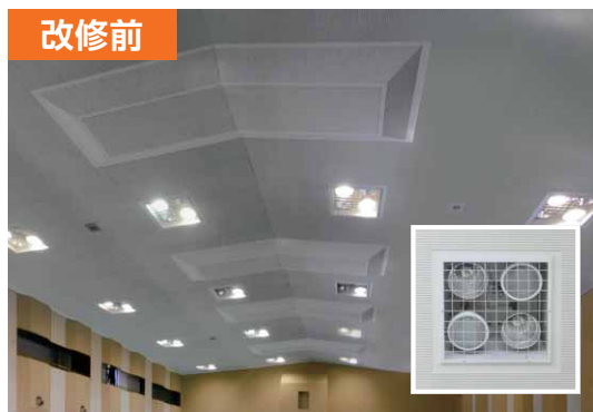
HID400W器具と150W投光用器具設置の改修前の講堂
