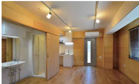
2本のライティングレール上にLED一体形スポットライトを設置した賃貸ルームの照明例 入居者が好みに合わせて照明器具を設置可能
