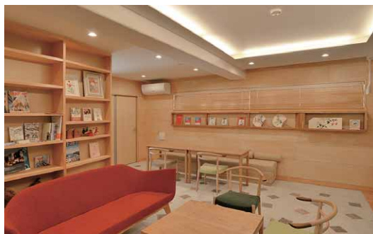
1階コミュニティラウンジは折り上げ天井を取り巻く形で電球色のLED一体形高気密SB形ダウンライトを配置
