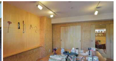
木工や造形が行える1階アトリエには作業に合わせて位置も向きも変えられるLED一体形スポットライトを採用
