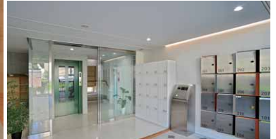
エントランスの照明 白熱灯器具60WクラスのLED一体形高気密SB形ダウンライト(5000K)をベース照明に採用
