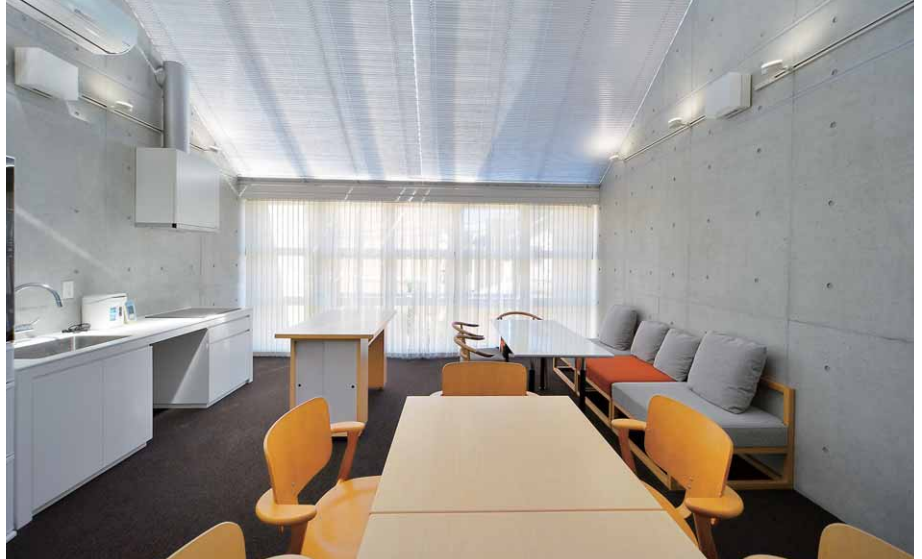
2階の入居者がシェアするラウンジは壁面にライティングレールを設けLEDユニットフラット形フランチタイプスポットライトで間接照明
