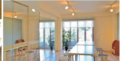
ダンス教室など多用途を想定した集会室の照明器具は、自由に照明演出ができるようライティングレールを利用
