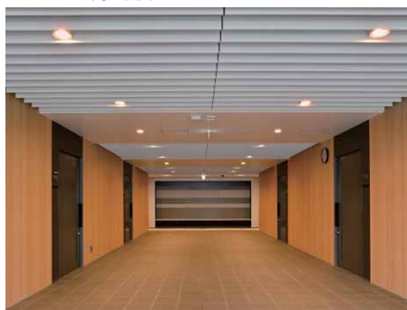
ルーバー形状のデザインをもつ天井に電球色のLEDライトエンジン直付ダウンライトを配置した1階ピロティ
