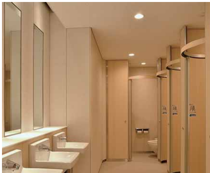
人感センサーによって点滅するトイレのLED照明
