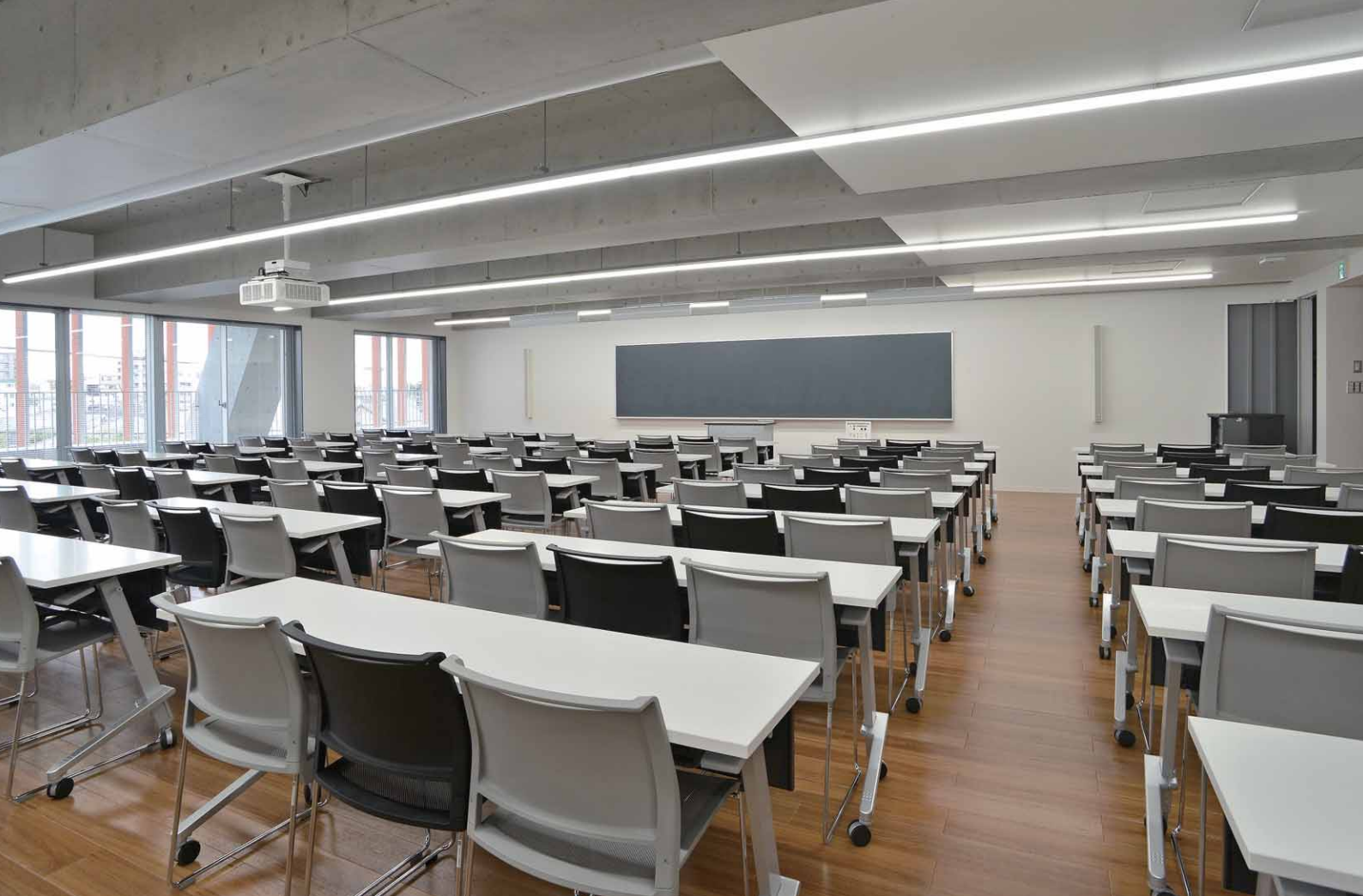
中教室のLEDベースライト TENQOOシリーズ連結のライン配置による照明
