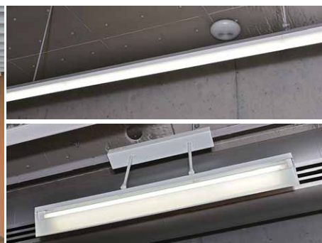
(上) LEDベースライト TENQOOシリーズの連結配置 (下) 直管形LED吊下形（照射角度切替可能形）黒板灯
