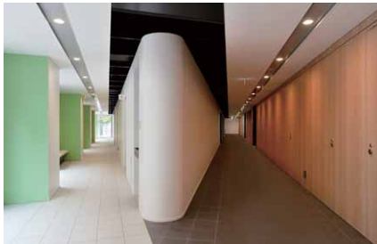
V字状の廊下に直線的に配置されたLEDライトエンジンダウンライト
