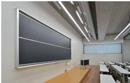
グレアカットし、かつ照度ムラの少ない直管形LED吊下形黒板灯を採用
