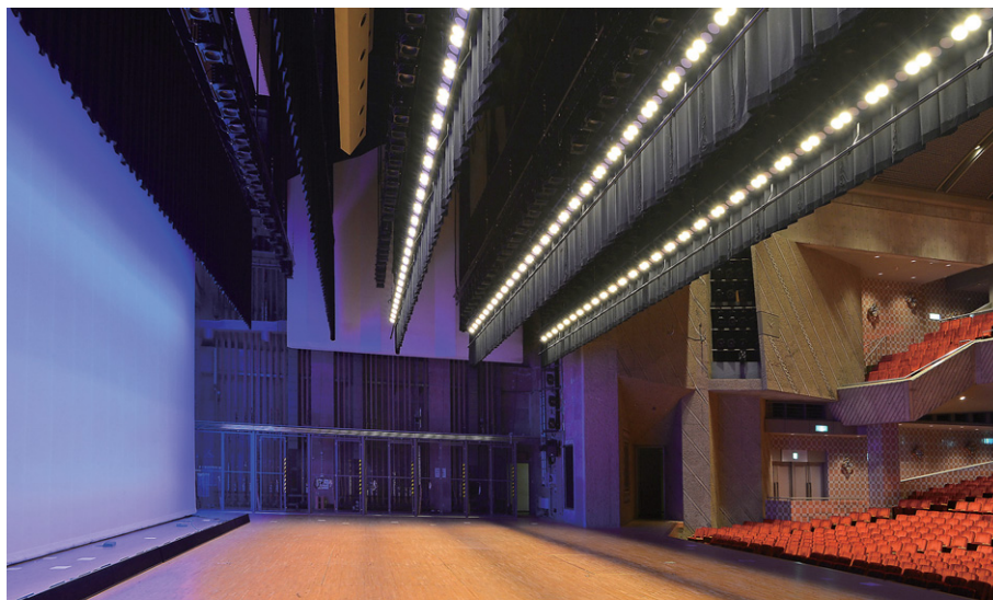
3列に並ぶLEDボーダーライトとLEDホリゾンライトによる舞台照明
