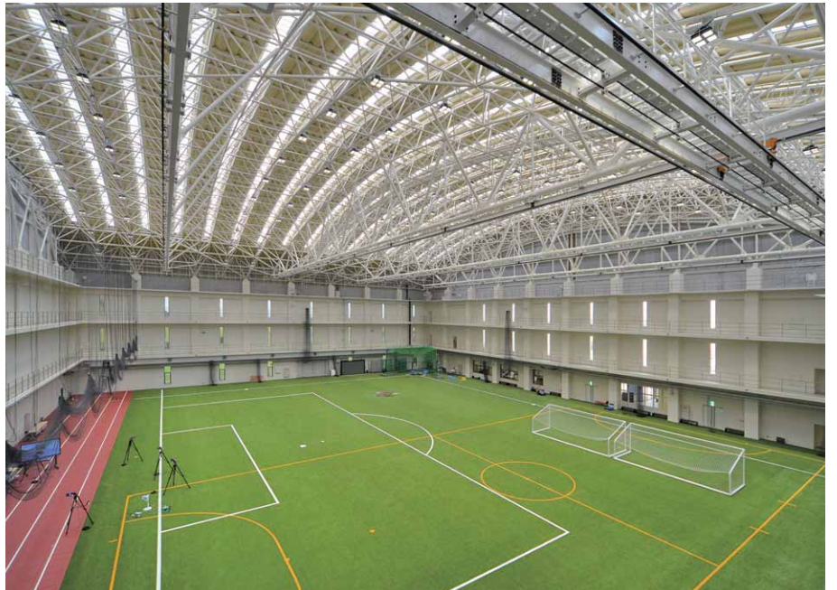
1kW形金属ハイドランプ高天井器具相当のLED高天井器具を採用した最先端研究設備を数多く備えた測定アリーナ
