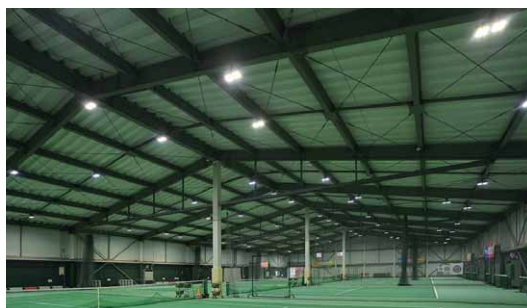
コートのコーナー部にはHID器具1kW形相当のLED高天井器具を配備
