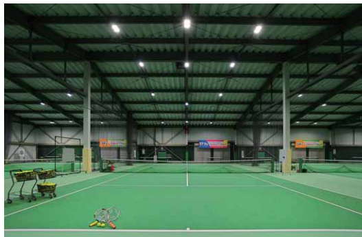
コート1面当たりHID器具400W形相当のLED高天井器具を15台配置
