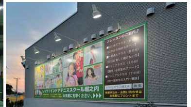
道路側壁面に設けられたLED小形投光器による看板照明
