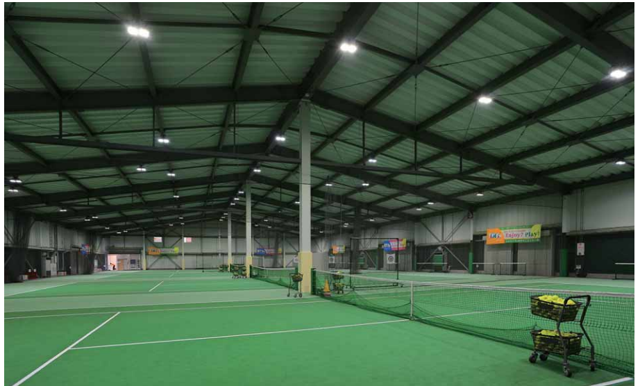
インドアコートの天井には、LED高天井器具を左右対象配置で合計60台を設置
