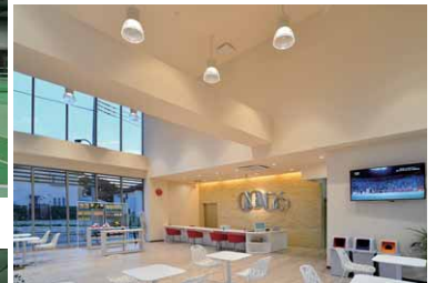
エントランスホールの照明 LEDロフトペンダント透明プリズムタイプを配置
