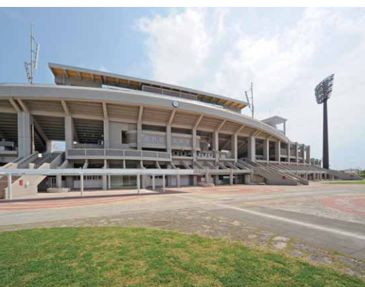
メインスタンド(外観改修、風除室・キャノピー新設)
