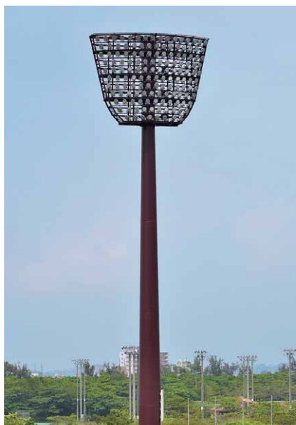
LED投光器141台を搭載した約50m高の照明塔
