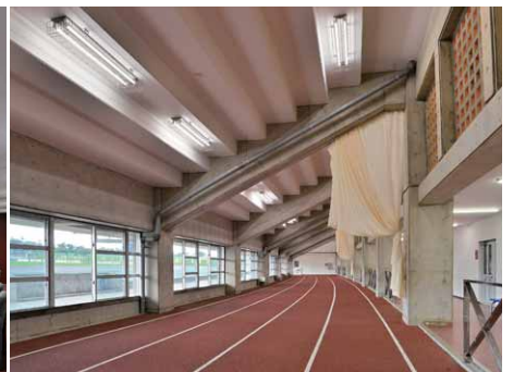
ウォーミングアップルームの照明直管形LEDベースライト逆富士形器具ガード付を均等配置
