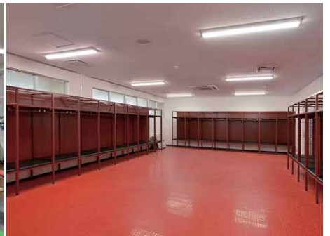
ロッカールームの直管形LEDベースライト逆富士形器具ガード付
