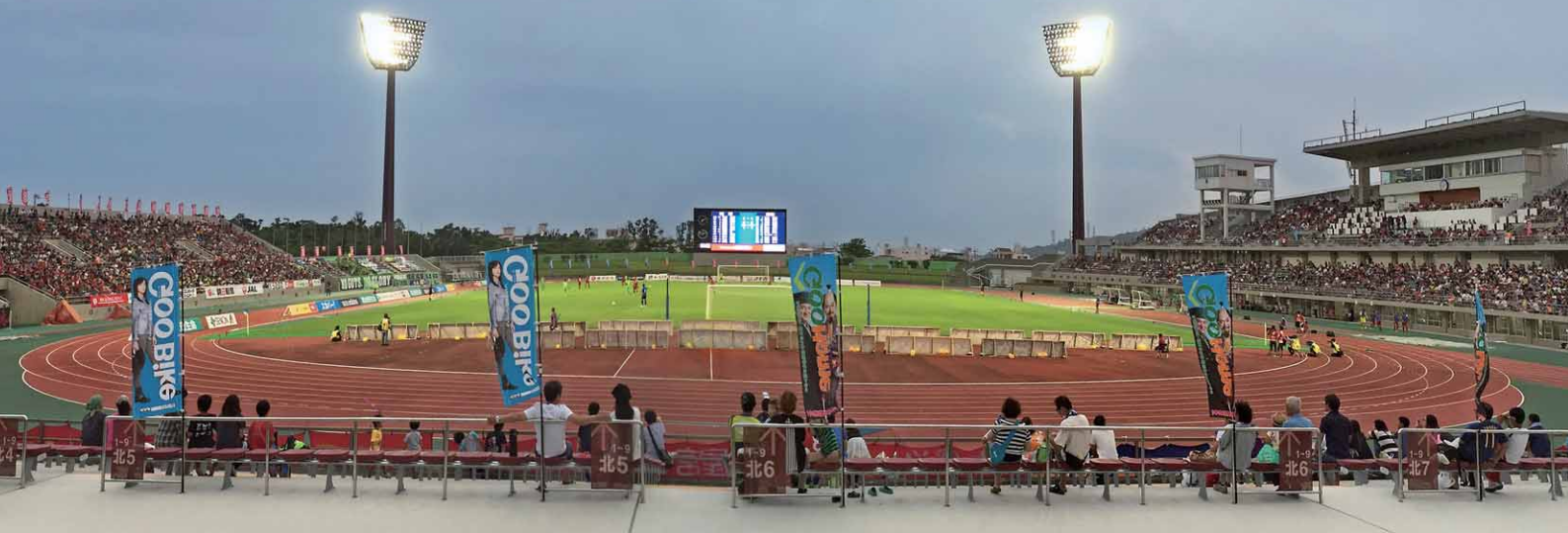
フィールドのナイター設備 省エネ性能に優れ、かつメンテナンスフリーのLED投光器を1基当たり141台搭載の照明塔×4基を配置
