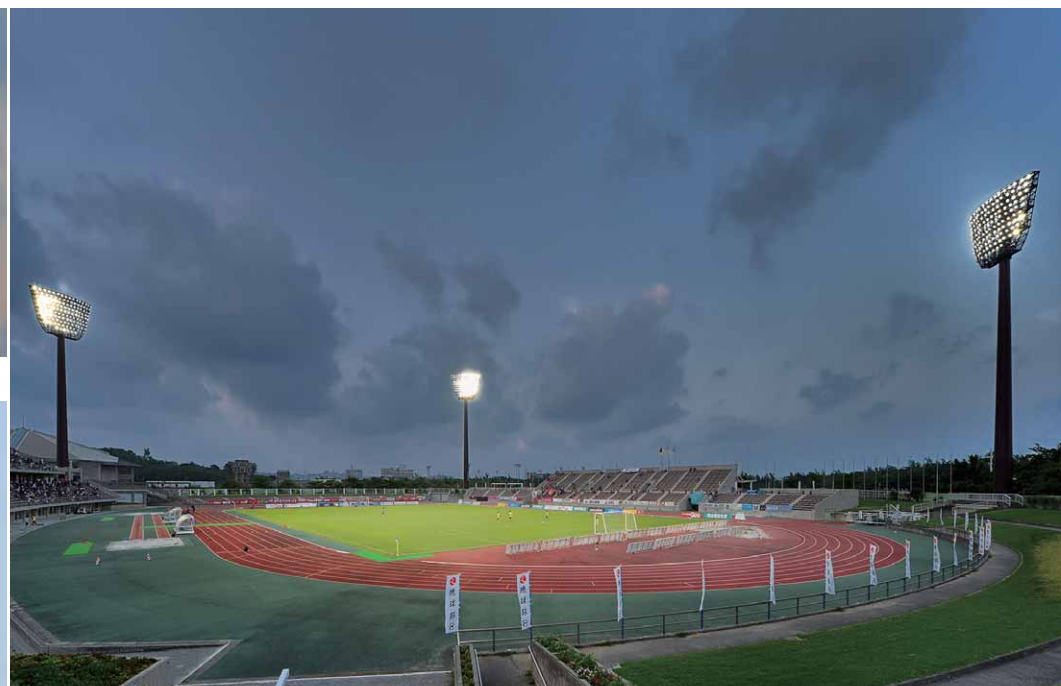
LED投光器の点灯パターンはリーグ点灯で1500ルクス、陸上競技時は全国大会レベルからレクリエーションレベルまで照明制御にて幅広く対応
