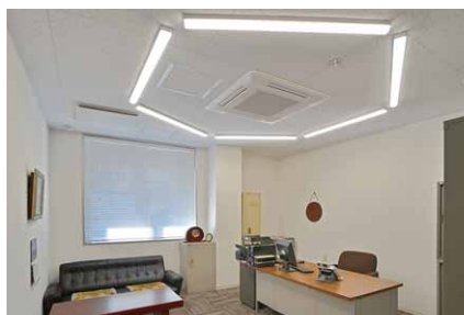
TENQOOシリーズによる社長室の照明
