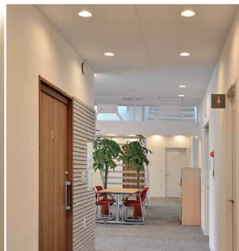
廊下のLEDダウンライトによる照明
