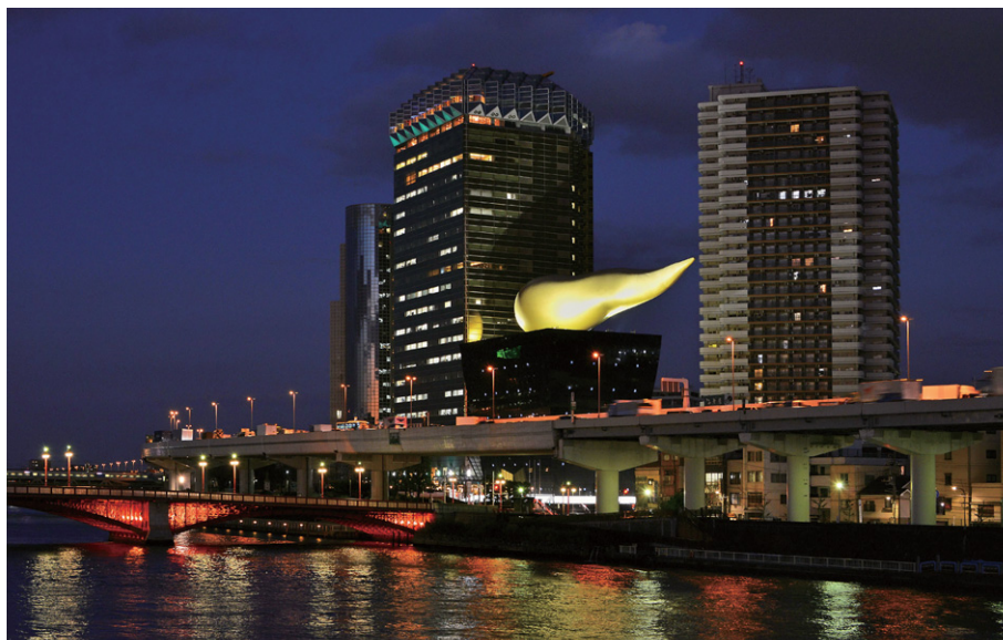
駒形橋の視点からの全景 吾妻橋を横に、モニュメントの形状が伸びやかにかつ単独で浮かび上がるため、最も美しい情景を見ることが出来る
