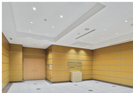
LEDライトエンジンダウンライトによるエントランスの照明
