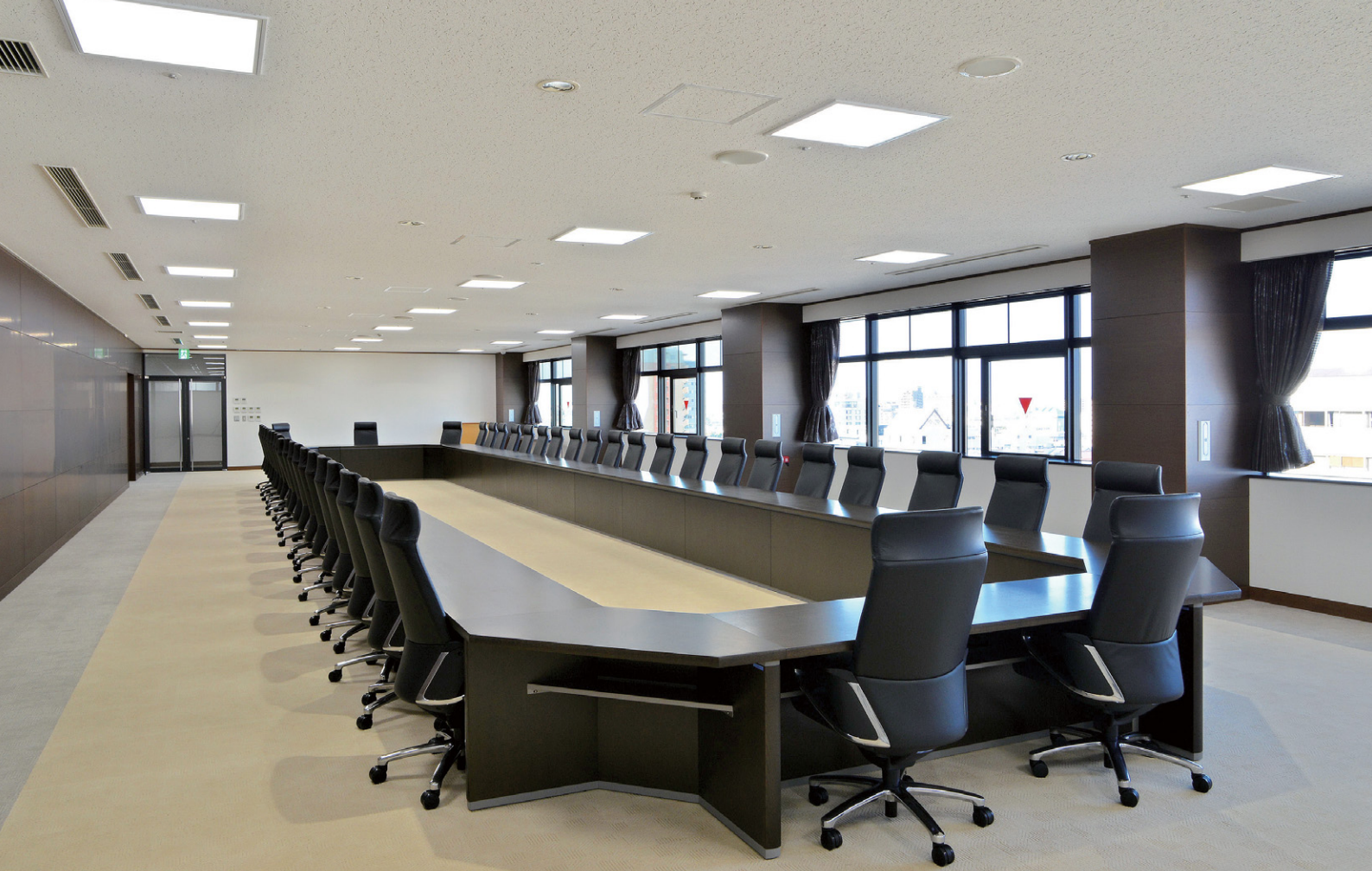
8階特別会議室の照明 乳白カバー付LEDベースライト一体形スクエアタイプを均等配置
