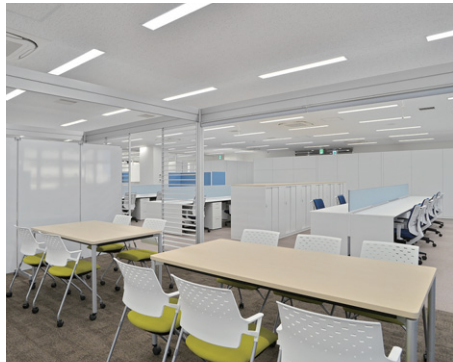
執務室内打ち合わせコーナーのLED照明
