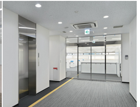
LEDダウンライト+人感センサーによるON/OFF制御のエレベーターホール
