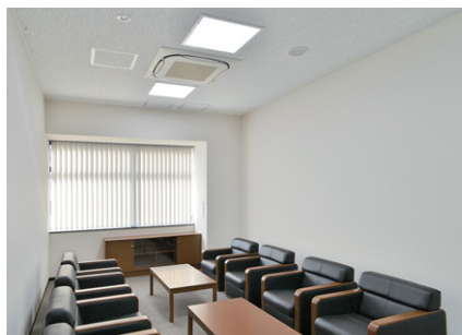
乳白カバー付スクエアタイプによる応接室の照明
