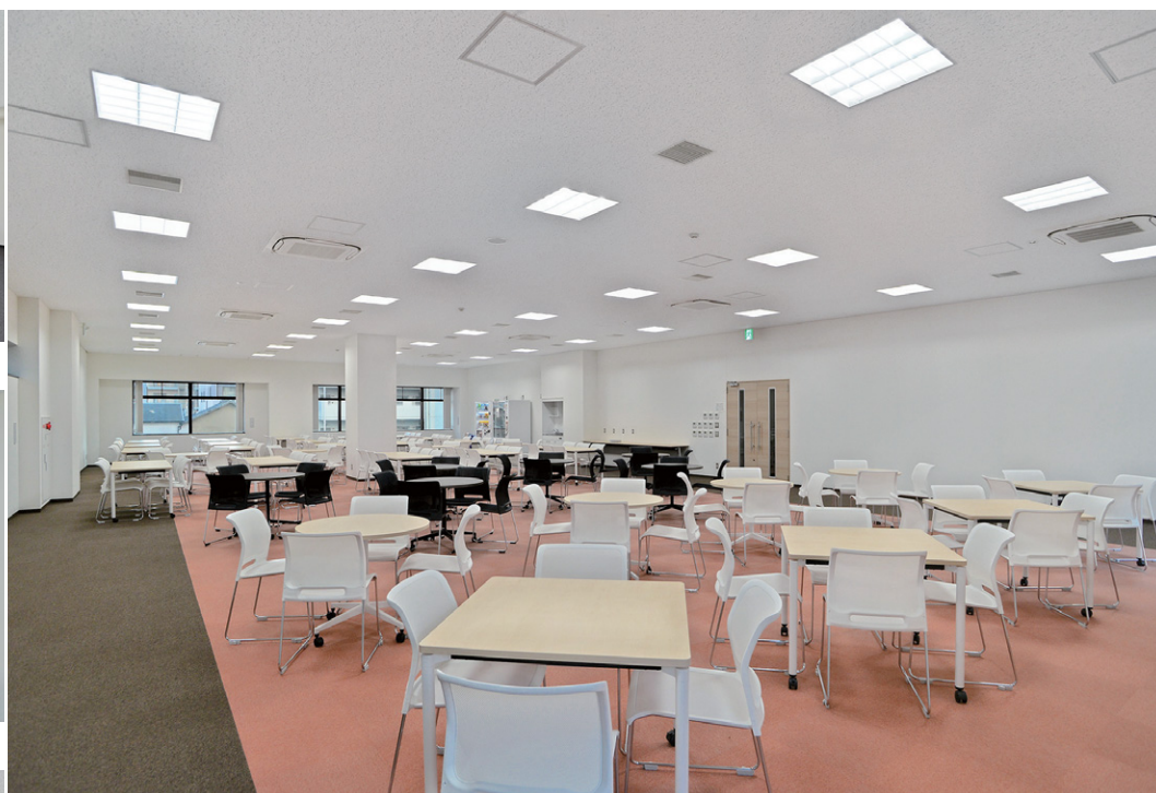
食堂の照明 天井面がスッキリする埋込器具のLEDベースライトTENQ00シリーズスクエアタイプパツプル付を採用し、心地よい空間を演出
