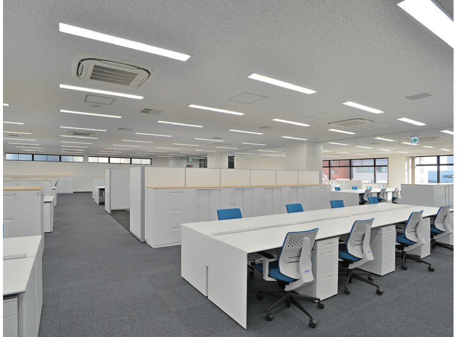
4階オフィスフロア執務室の照明 LEDベースライトTENQOOシリーズ埋込形昼白色を均等配置、レイアウト変更時にもフレキシブルに対応可能
