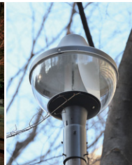
遮光板を取付け、光漏れ を抑制したLED街路灯
