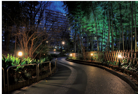
竹林内部にはLED小形投光器を採用 通路部はLED低位置照明
