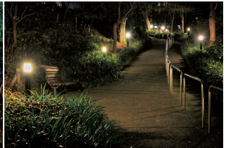
庭園内通路の既存高位置照明を撤去し、低位置照明を設置して落ち着いた雰囲気を出し
