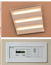
(上) 調光調色照明器具 (下) 照明制御コントローラー
