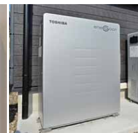
電気を蓄えて効率よく使用できる定置式蓄電池
