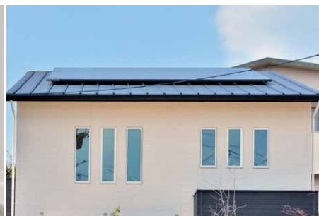
キッチン内にHEMS対応の冷蔵庫、スマートコンロなどを配置 屋根に設置された太陽光発電システム（4kW）
