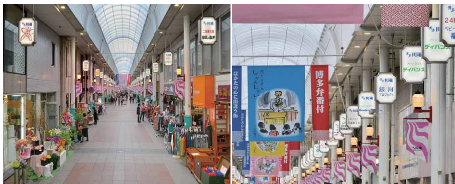
LED看板灯は天井から吊り下げ地上約6m高に設置
