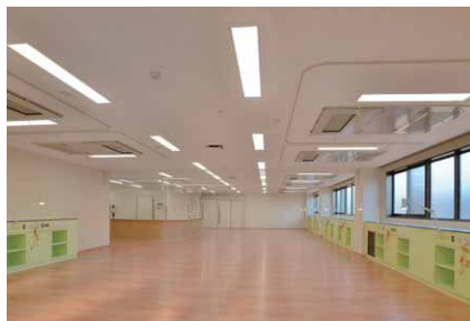
TENQOOシリーズを設置したHCU室(高度治療室)
