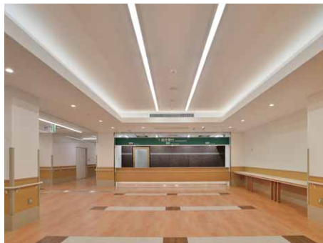
総合待合室の照明 中央にTENQOOシリーズと間接照明、下がり天井にはLEDダウンライトを配置
