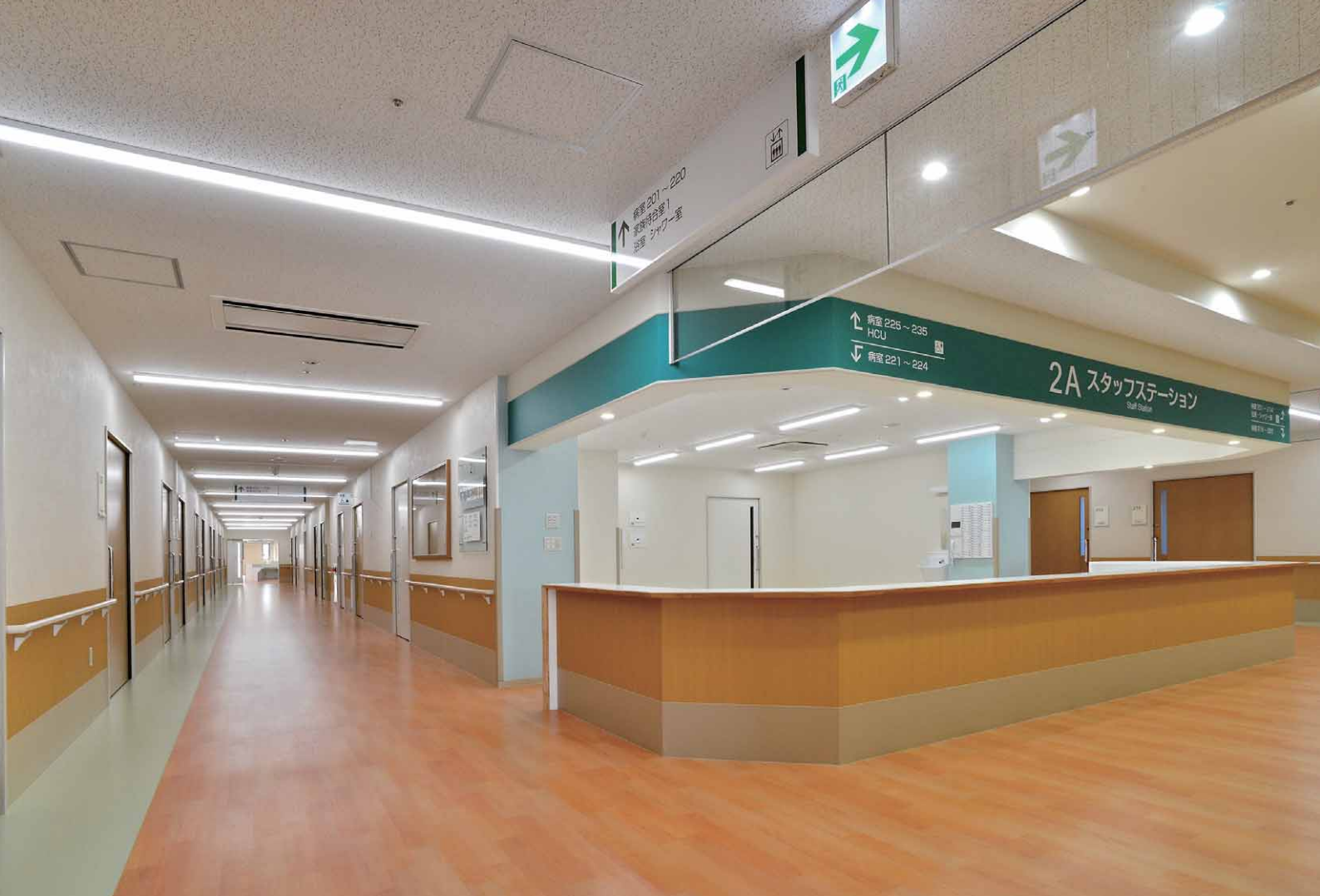
TENQOOシリーズによる廊下の照明とスタッフステーションのLED照明。スタッフステーションのカウンター上にはLEDダウンライトを配置
