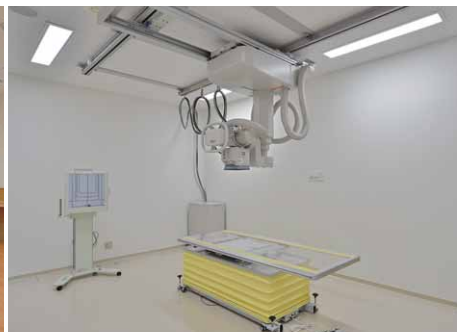
TENQOOシリーズ調光タイプによるX線撮影室の照明
