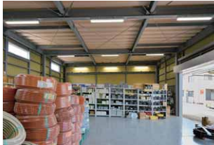
TENQOOシリーズ直付形40タイプを採用した倉庫の照明
