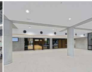
1階エントランスホールのLED照明
