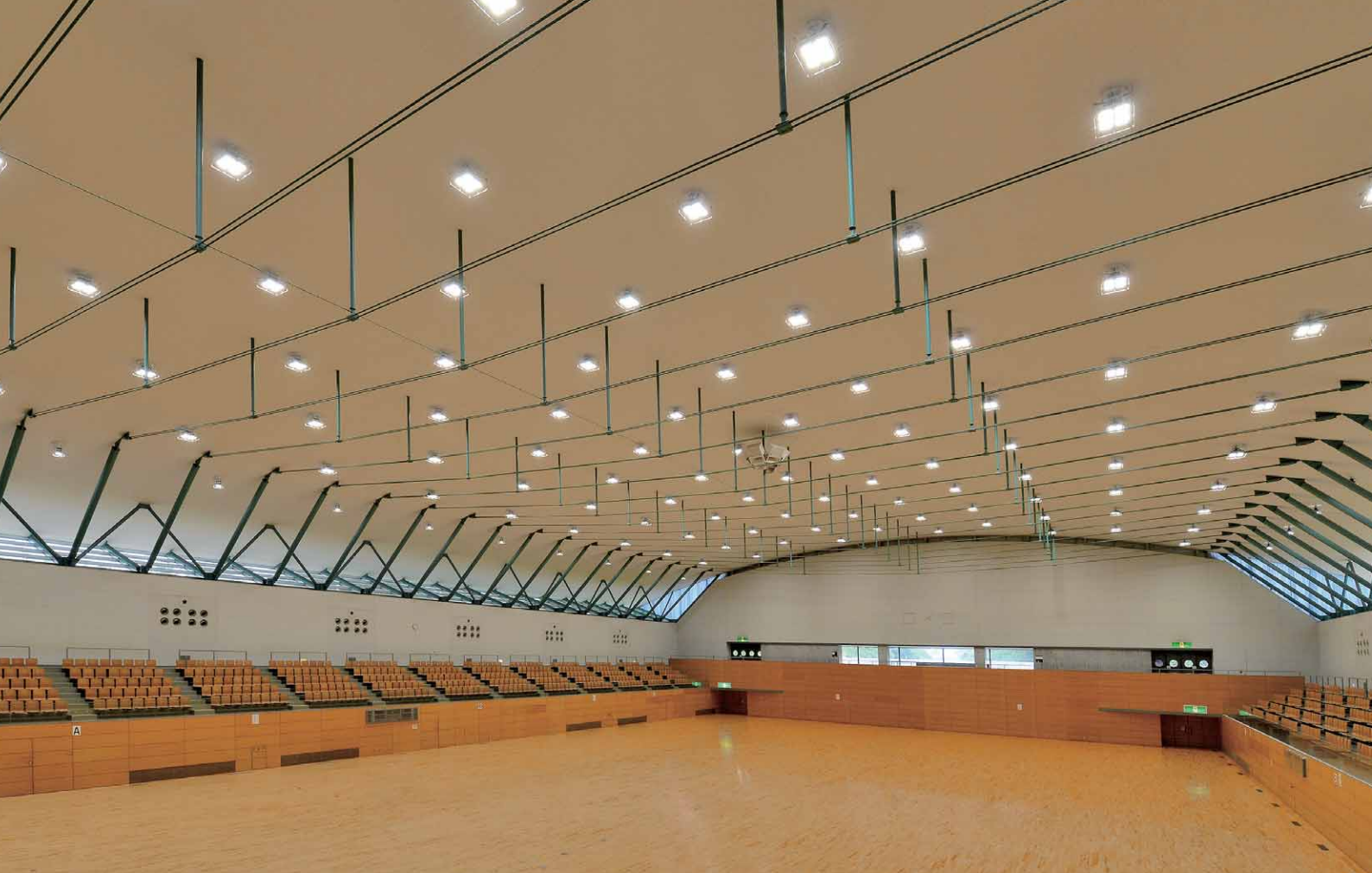
大体育館アリーナの照明 LED高天井器具拡散カバー付下面ガード+体育館用ガードが装備され、グレアの軽減を図るとともにバレーボール等の強打による衝撃にも対応
