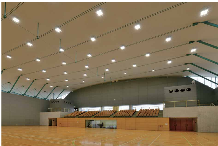
既存のHID器具からLED高天井器具に更新した小体育館のアリーナ
