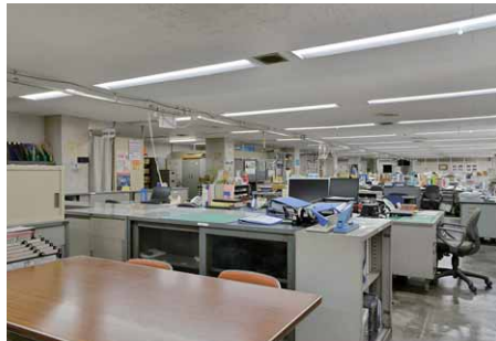
LEDベースライトTENQOOシリーズ埋込110形と40形に更新した1階事務所
