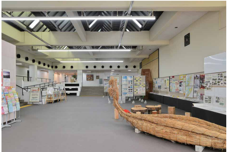
エントランスロビーの照明風景 吹抜空間の開放感を生かす吊下設置のLEDベースライトTENQOOシリーズ直付形器具
