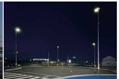
道路交差点に採用された新型のLED道路灯 (H=10m)
