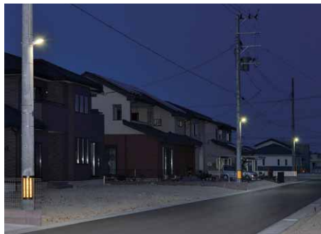
生活道路の電柱に共架されたLED街路灯
