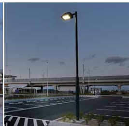
駅前駐車場に採用されたLED駐車場用照明 (H=4.5m)
