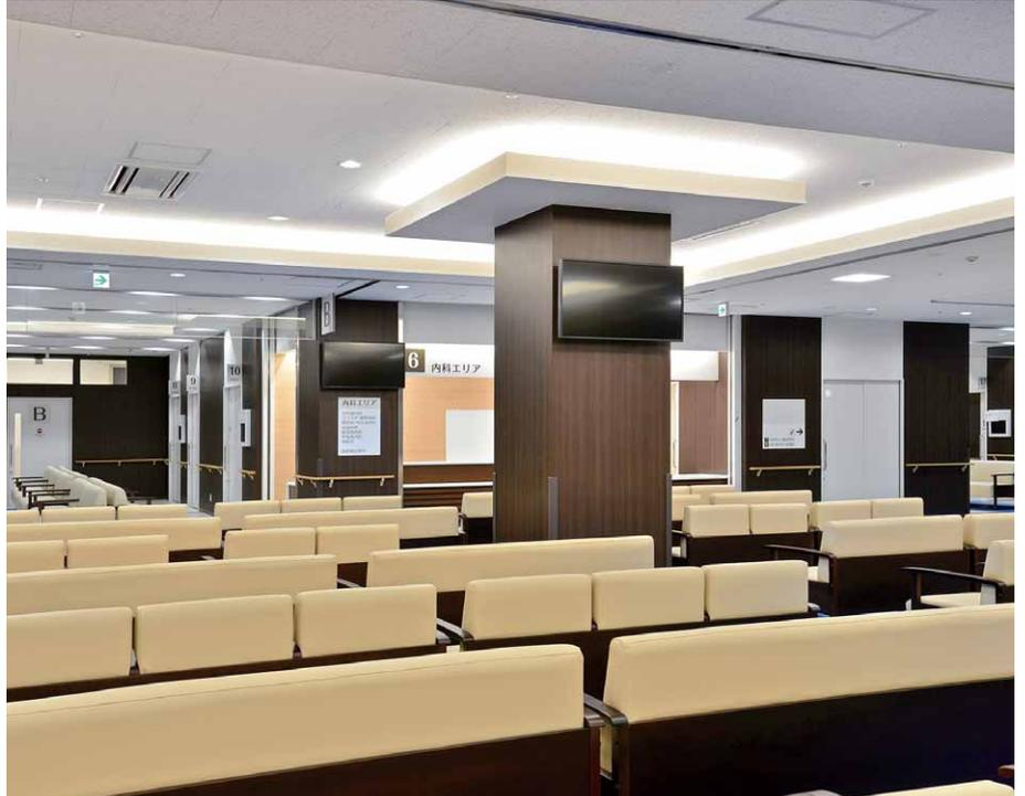
総合待合室の照明 天井中央部を折上天井とした建築化照明によりソフトな明るさ感の中で開放感を創出
