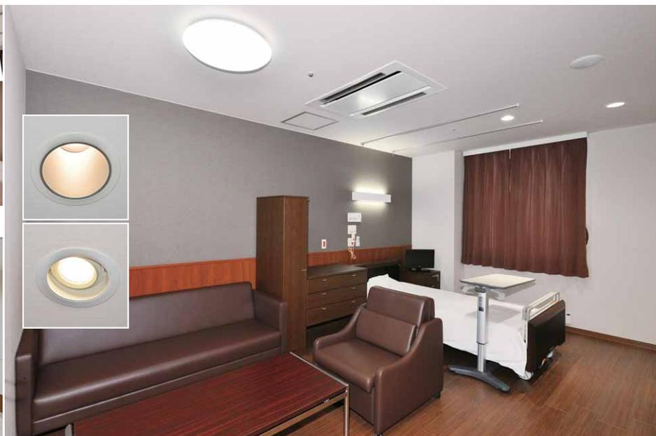
個室特別室の照明 ベースにはLEDホスピタルダウンライト(組込写真上)を、処置灯にはLEDユニバーサルダウンライト(組込写真下)を、ベッド灯にはLEDホスピタルブラケットを、ソファ上にはLEDシーリングライトを採用
