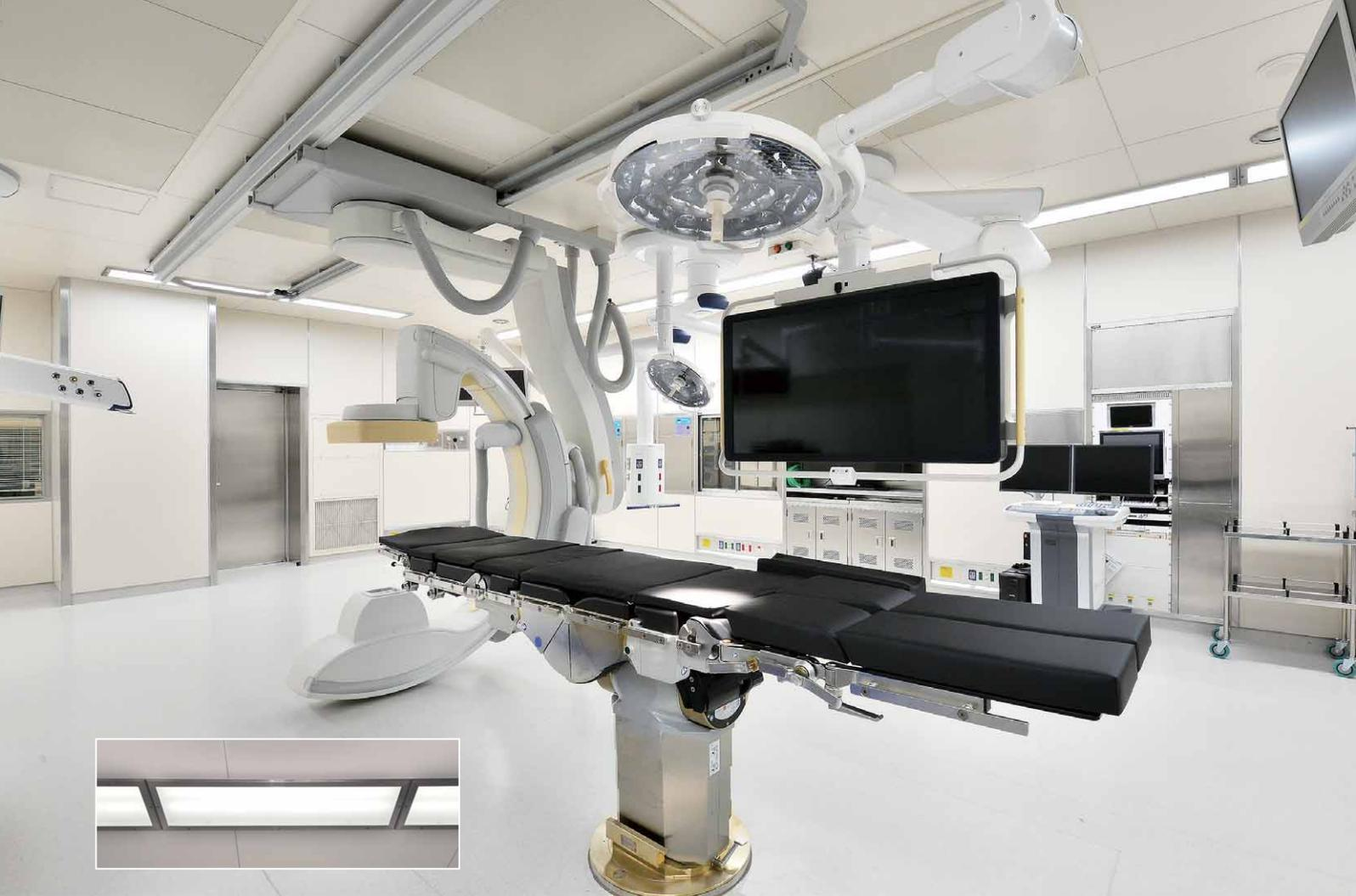
LEDクリーンルーム用器具カバーガラス飛散防止膜付を採用した手術室の照明 手術台を囲む形で壁面側に設置し医療スタッフが集中的に治療できるよう高強度でサポート
