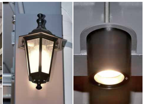
1番線ホームの柱に配置したLEDブラケット
