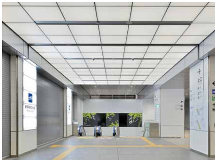
新幹線改札側の南北自由通路は光天井としてその内部にLED照明を採用。左側の柱の看板灯にもLEDモジュールを設置
