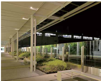
ガラス窓側の交流・対話空間に配置した南北自由通路のLEDユニバーサルダウンライト
