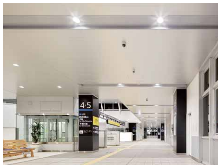
駅構内通路のLED照明(昼光利用制御)
