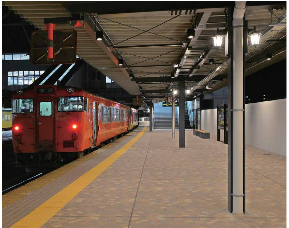
SL「やまぐち」号が停車する新山口駅1番線ホームの柱には床面約3m高にクラシカルで優雅なLEDブラケットとLEDシーリングライトを配置し、レトロな雰囲気を助長
