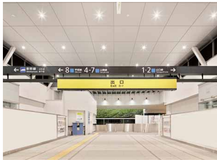
新しく改装され、広々としたエントランス空間に高出力タイプのLEDダウンライトを設置(昼光利用制御)
