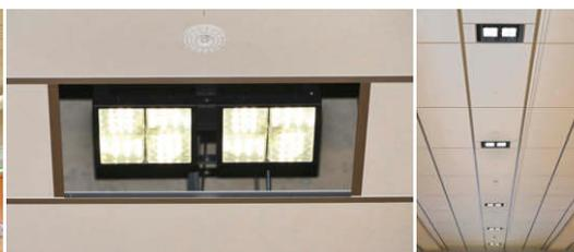
(左)設置高さが大きく(高さ9m)、天井面に埋め込むことにより体育館用ガードを不要に/ (右)コンパクトな器具形状により、天井面に埋め込まれていた既存器具の設置穴をそのまま利用
