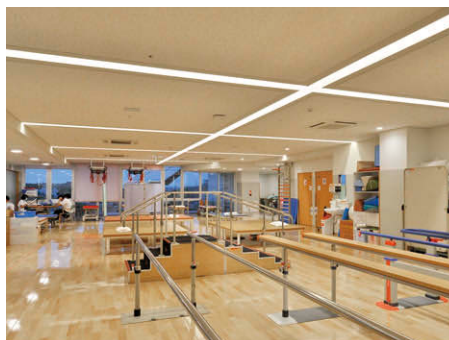
折上天井のスリットライン内にLED照明を配置したリハビリ室
