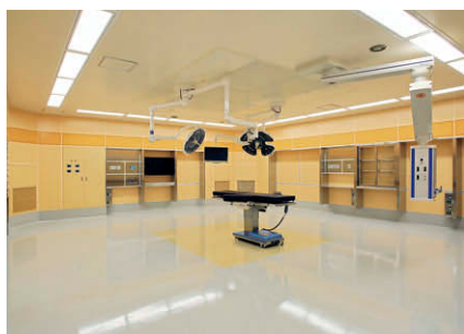
LEDクリーンルーム用器具採用の手術室
