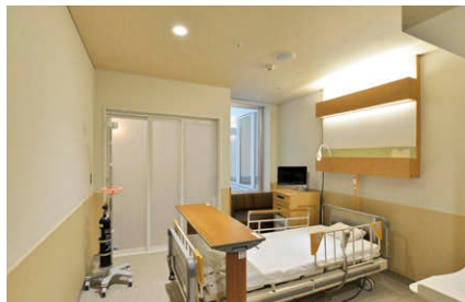
病室の照明 ベースにLEDダウンライトのほか、LED読書灯(ベッド灯)とLED間接照明などを採用
