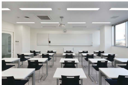
LED埋込器具を均等配置した一般教室
