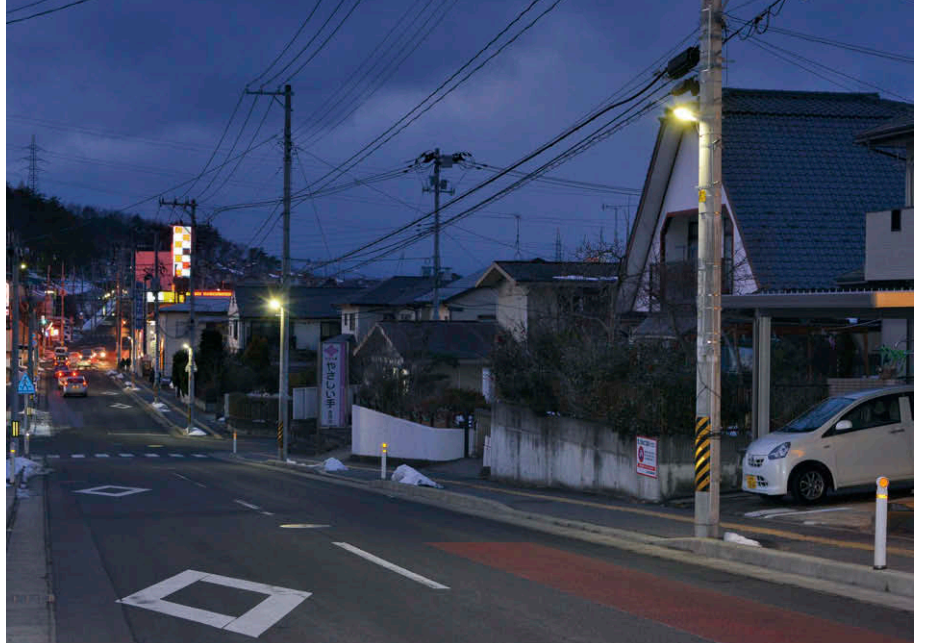
仙台市泉区のLED防犯灯 電柱4.5m高に共架して生活道路の端まで照射
