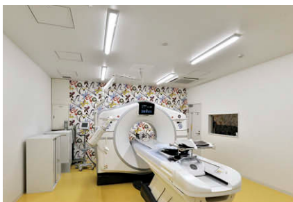
LED照明調光形を採用したCT検査室
