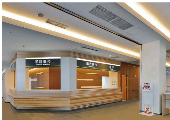
LED間接照明とLEDダウンライトを主とする総合受付の照明
