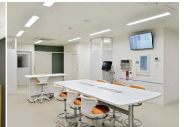
TENQOOシリーズによるスタッフステーションの照明
