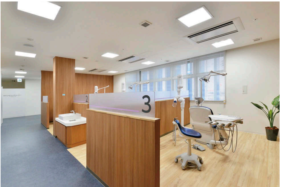
LED一体形スクエア器具乳白カバー付とバツフル付による歯科診察室の照明
