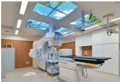
高精度放射線治療室のLED照明調光可能形
