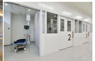
LEDダウンライト、TENQOOシリーズ埋込器具による救急救命室
