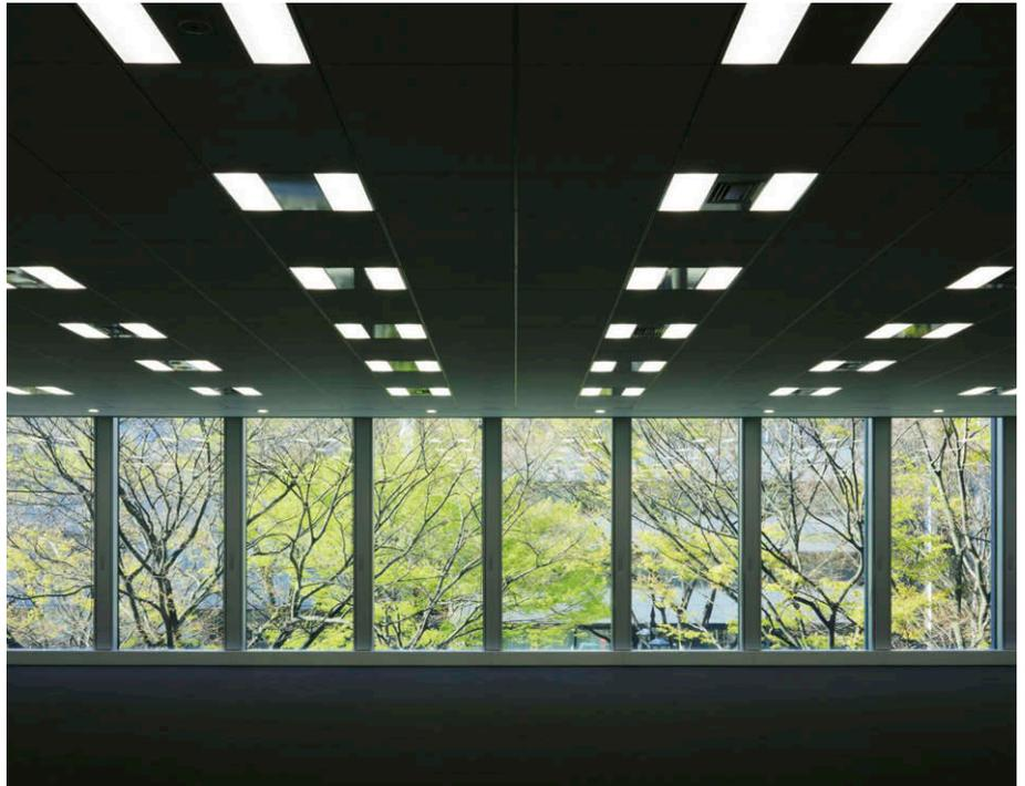
基準階オフィス執務室の照明 特注のLEDシステム天井器具グリッドタイプを採用し、あかりセンサーによる昼光利用制御でさらなる省エネ
