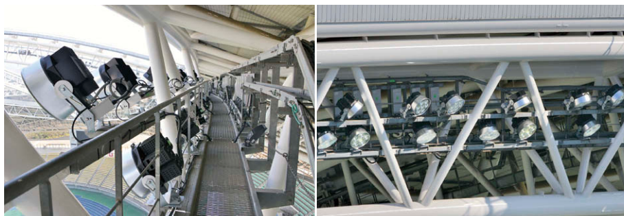
フィールド照明のLED投光器配置の状況 固定屋根先端のアーチフレームとセットバックした照明架台に上下2段の直線配置としている
