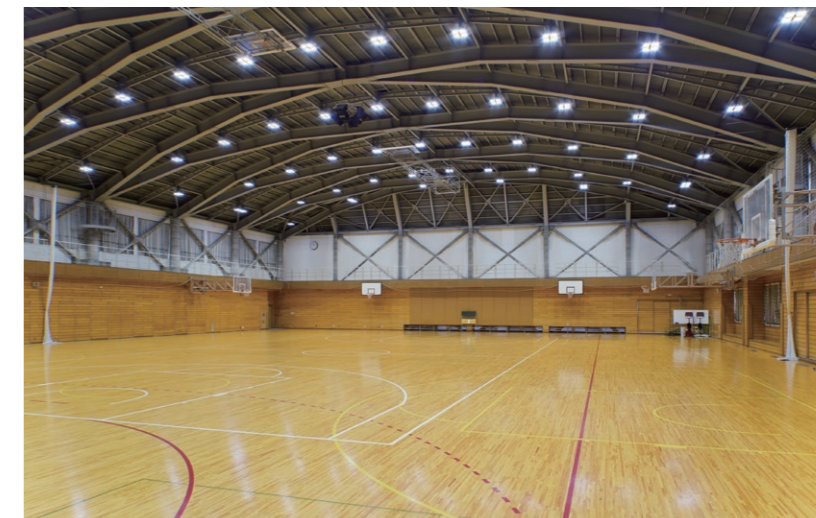
Aアリーナの照明 2013年にLED高天井器具①へ更新。60,000時間の光源寿命による省メンテナンス効果を実感されています
