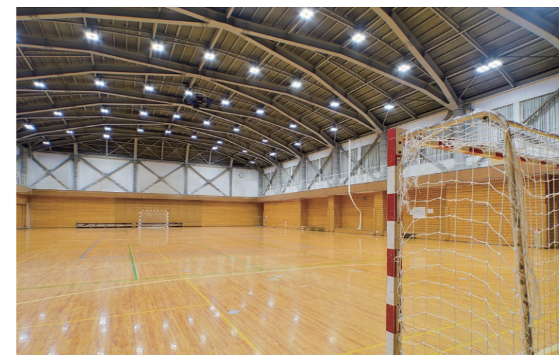
Cアリーナの照明 2015年にLED高天井器具②へ更新。主にハンドボール、器械体操、フェンシングなどに使用
