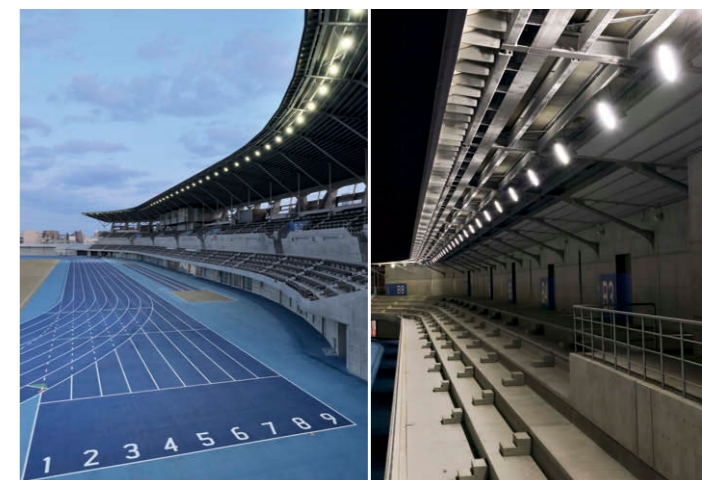
メインスタンド屋根(高さ18.4m)に400W形LED投光器②が等間隔で並べられたバックスタンド屋根
