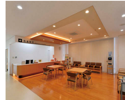
外来受付の照明 LED一体形ダウンライト電球色②とLEDライン器具③による間接照明
