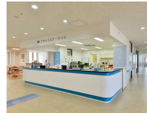
医療療養病棟のスタッフステーション その周辺の廊下には目に優しい遮光角15°のLEDライトエンジンダウンライト①を均等配置
