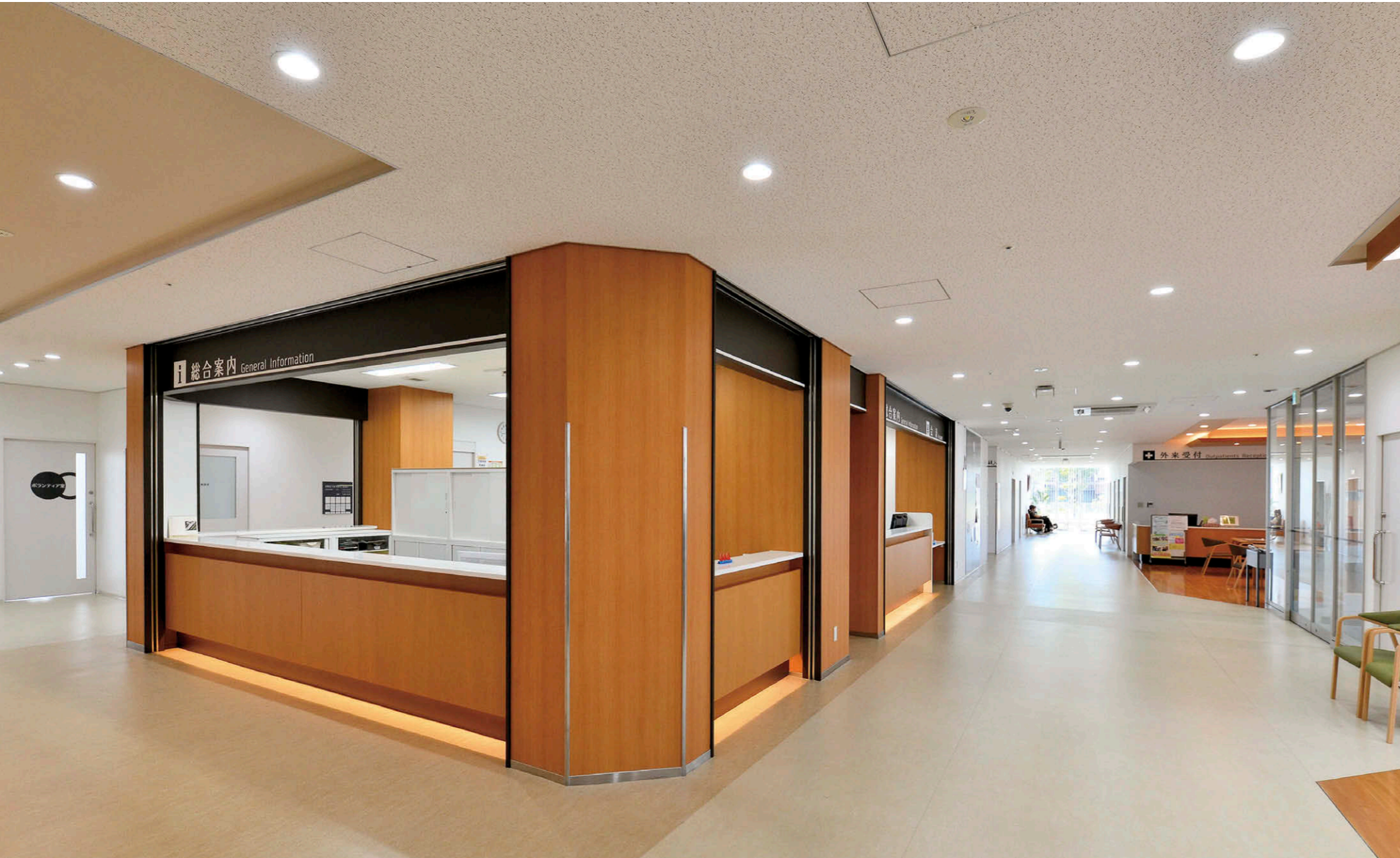
1階外来フロア・総合案内周辺の照明 外来診察室や通所リハビリテーション室への患者移動通路は遮光角15°のLEDライトエンジンダウンライト昼白色①を配置
